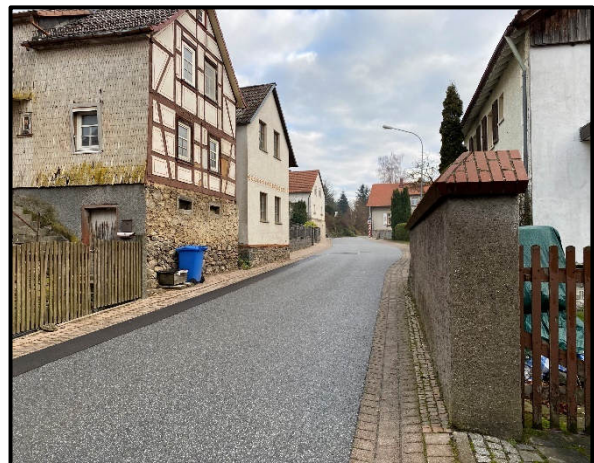
Straßenraumquerschnitt „Alt Allertshofen“ in Höhe der Stichstraße „Schöne Aussicht“; Aufnahme von Nordosten
