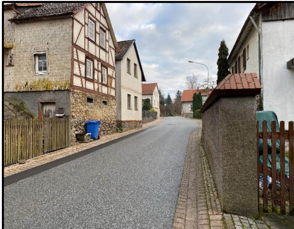
Bebauung entlang der Ortsdurchfahrtsstraße „Alt Allertshofen“, Aufnahme­richtung: Nordosten
